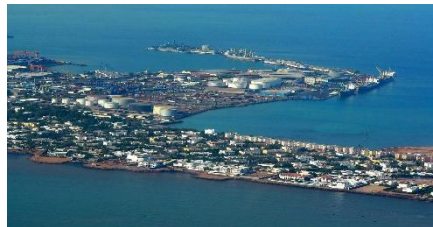
Ancien dépôt Mobil et Shell
