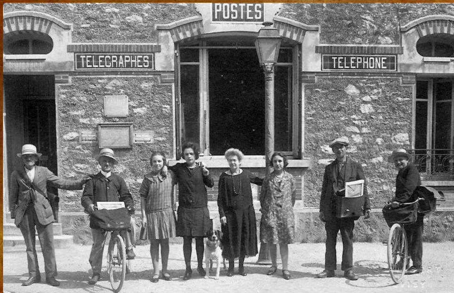
- La poste de Viry-Châtillon au début du XXème siècle
