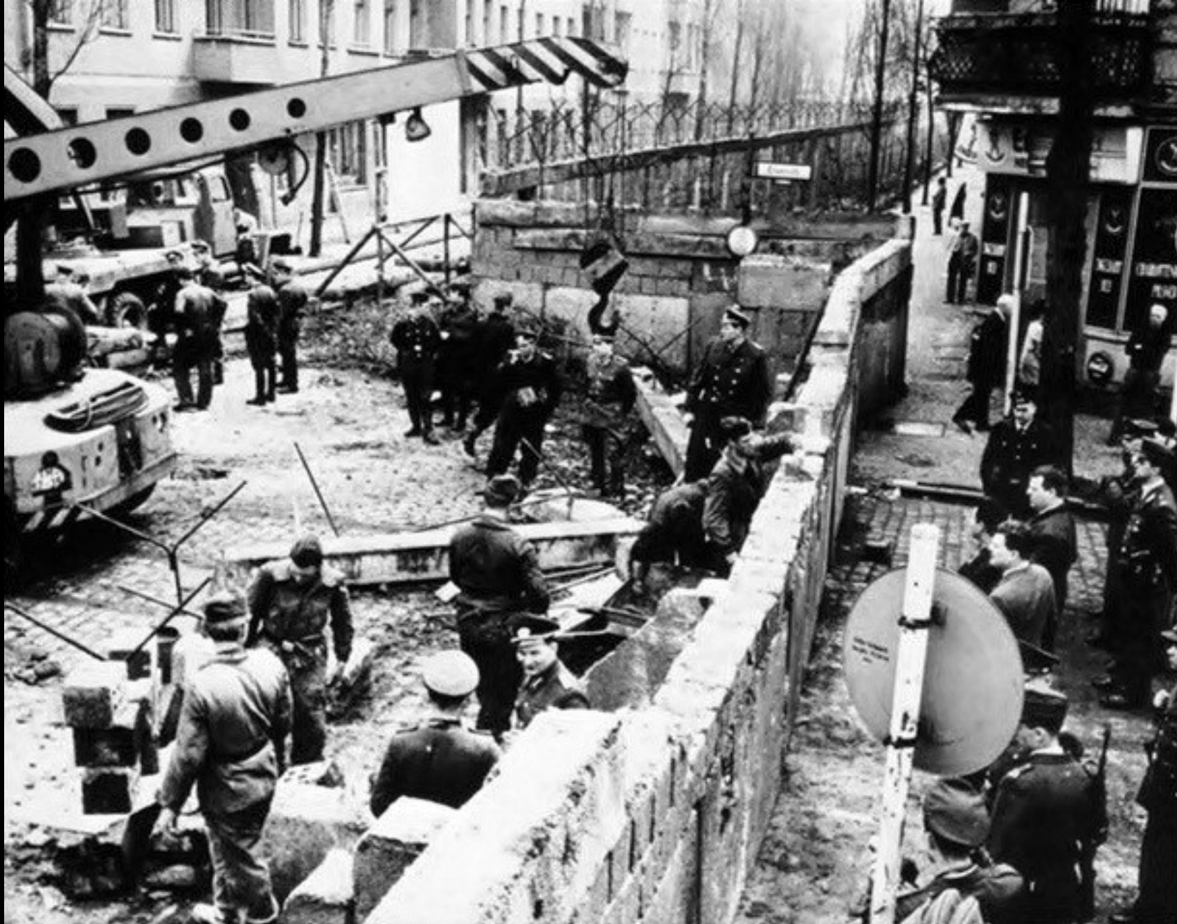
Construction du mur de Berlin en 1961
