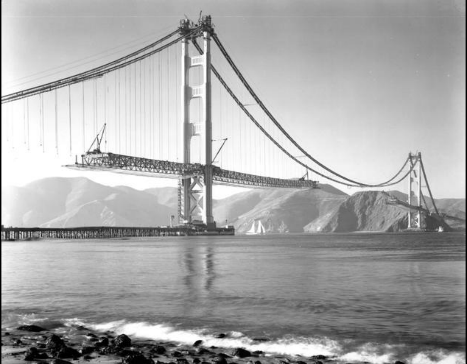
La construction du Golden Gate Bridge 1937
